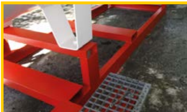
Auch die Gestelle der Flüssiggasbehälter/ Kompaktanlagen wurden neu beschichtet.
