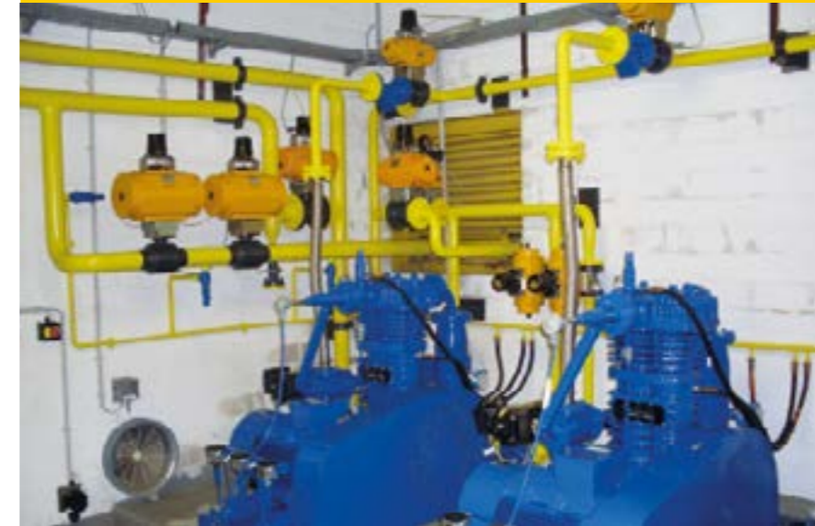
Alle Aggregate, Rohrleitungen und Halterungen sind in unterschiedlichen Farben lackiert, die Übergänge zwischen den Farben deutlich voneinander abgegrenzt.
