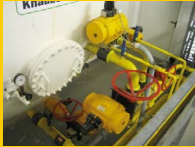
Lagerbehälter eines Flüssiggas-Lagers: Der Decklack an Behälter und Rohrleitungen zeigt stellenweise Haftstörungen.
