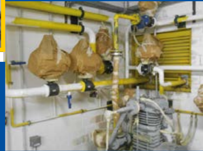
Öl- und Fettrückstände werden entfernt, alle nicht zu beschichtenden Aggregate abgedeckt bzw. abgeklebt. Flächen, auf denen die vorhandene Altlackierung keine ausreichende Haftung bietet, werden vorgeschliffen und grundiert.
