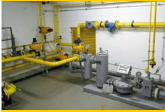
Aggregate und Rohrleitungen im Technikraum eines Flüssiggas-Lagers: Die Oberflächen sind stellenweise durch Öl- und Fettrückstände verschmutzt.
