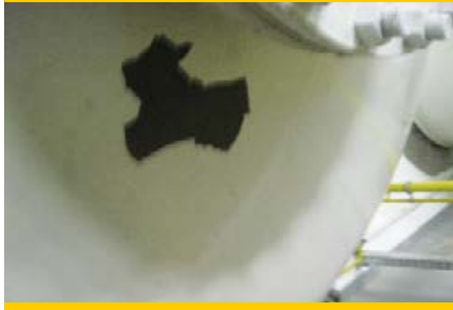
Lagerbehälter eines Flüssiggas-Lagers: Der Decklack an Behälter und Rohrleitungen zeigt stellenweise Haftstörungen.
