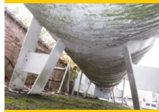
Schäden an Flüssiggasbehälter und Wetterschutz, hervorgerufen durch die Vegetation hinter der Anlage
