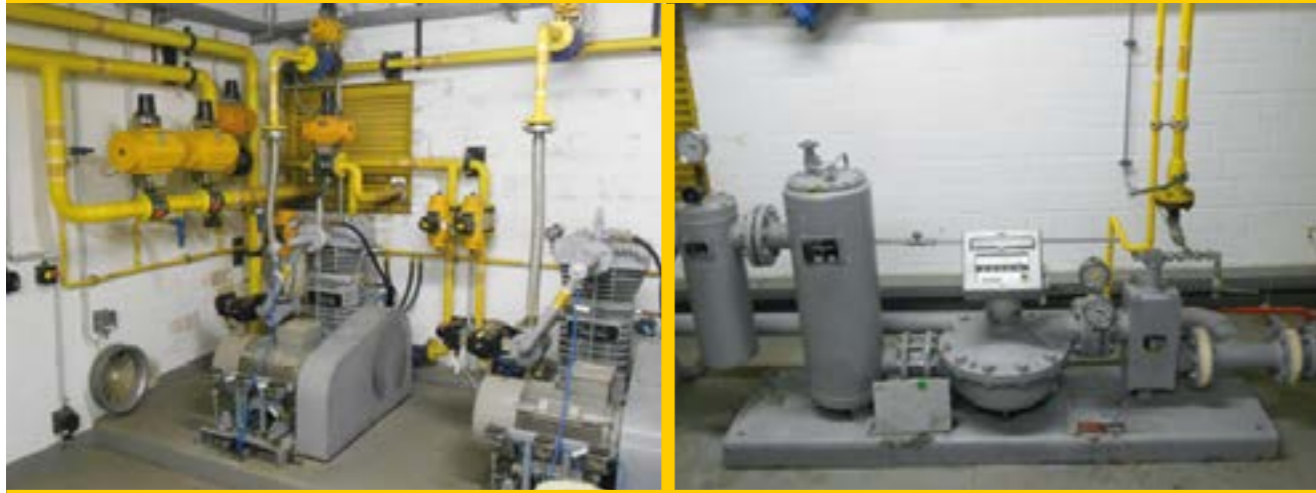
Aggregate und Rohrleitungen im Technikraum eines Flüssiggas-Lagers: Die Oberflächen sind stellenweise durch Öl- und Fettrückstände verschmutzt.
