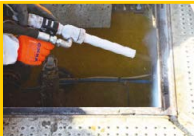
Reinigung verzinkter Schachtabdeckungen mit der Trockeneis-Strahltechnik
