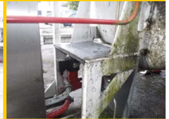
Schäden an Flüssiggasbehälter und Wetterschutz, hervorgerufen durch die Vegetation hinter der Anlage
