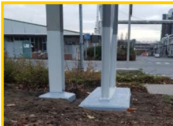
Erneuerung des Korrosionsschutzes der Stützen (Stahlprofilträgern) einer Rohrtrasse.
